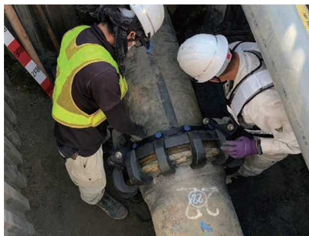
▲水道管をつなぐ継手部分に地震に強い補強金具を取り付けている状況
