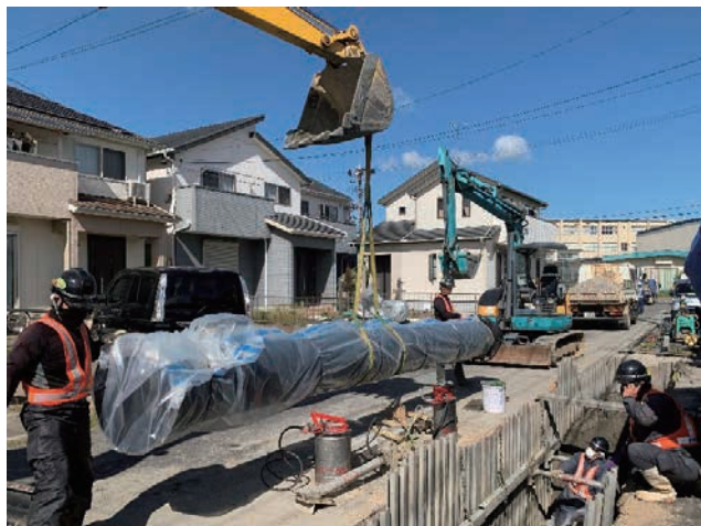
▲地震に強い水道管への取替工事の状況
