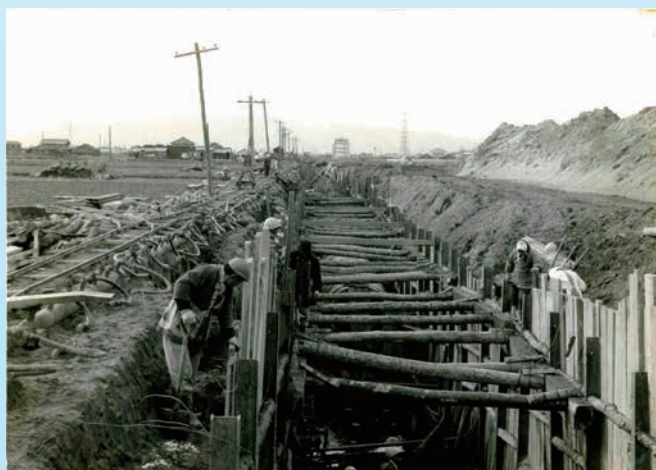
写真2 昭和37年(1962年)津島市消防本部前付近での下水道本管理設工事の掘削中の状況
