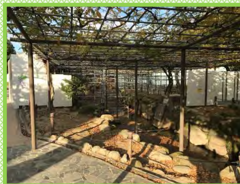
天王川公園藤棚再整備状況
