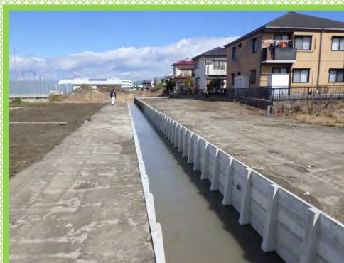
かんがい排水路整備状況
