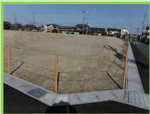
神守町地内公園整備状況
